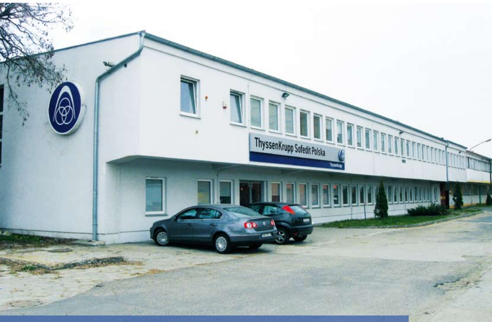
ThyssenKrupp Sofedit Poland
