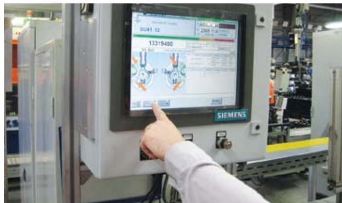
UCB nadzorujący pracę operatorów
