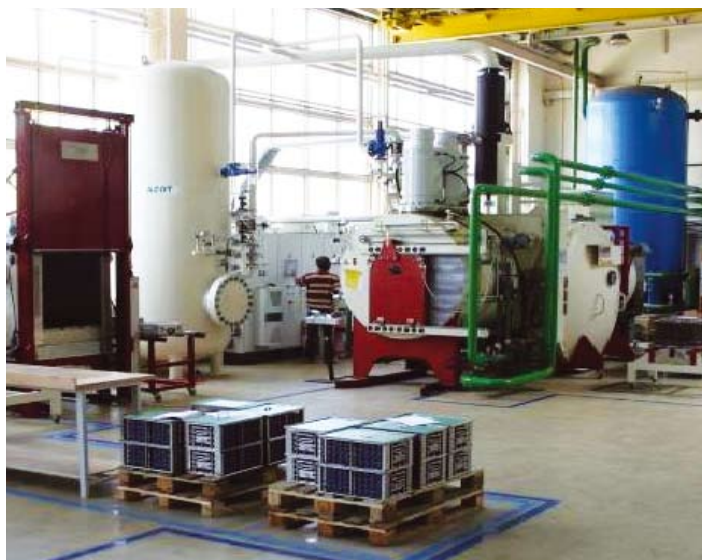
Instalacja do niskociśnieniowego nawęglania próżniowego LPC (Low Pressure Carburizing) w hartowni Bodycote w Warszawie
